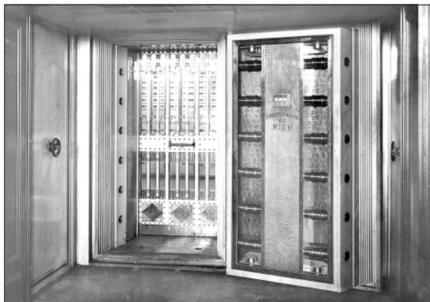
*Stahlkammertür einer Tresoranlage*
